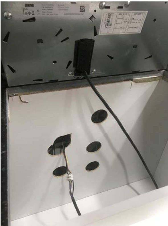
FOTO 21: DETALLE CONEXIÓN ENCIMERA VITRO SIN ENCHUFE
