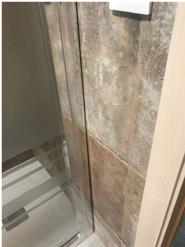
FOTO 27: DETALLE PARTE INFERIOR MAMPARA
