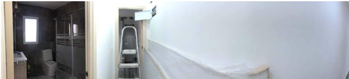
FOTO 2: VISTA GENERAL PASILLO 1 Y ASEO
