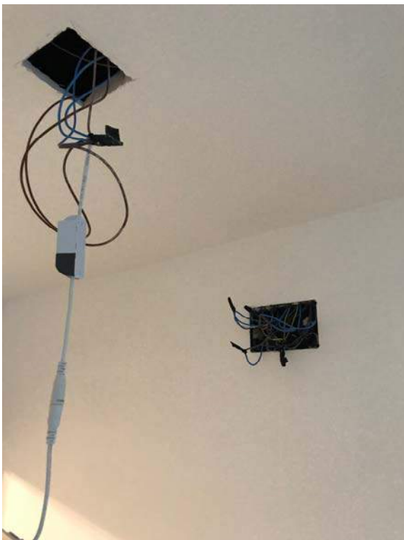
FOTO 15: VISTA GENERAL CAJA Y LAMPAR PASILLO 2
