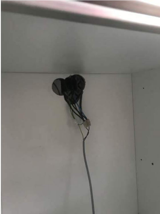
FOTO 22: DETALLE CONEXIÓN HORNO Y MICROONDAS VITRO SIN ENCHUFE
